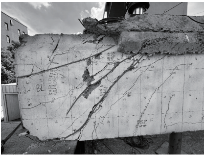
图6 试验组 6B 破坏情况现场实拍
