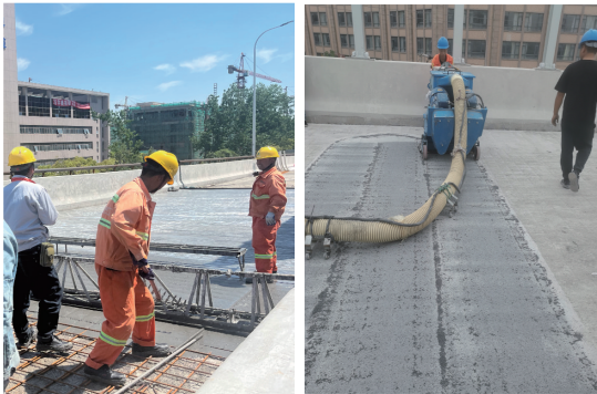
(a)混凝土施工 (b)表面抛丸 图 8 普通混凝土施工与表面抛丸凿毛
