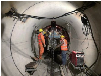
图 6 管道内设备拆除
