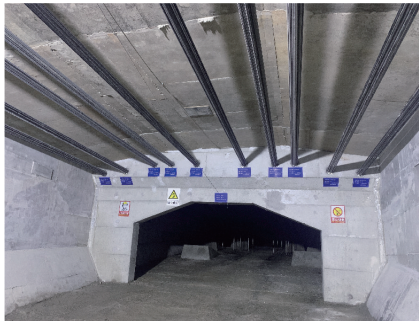
图4 转向块现场照片
