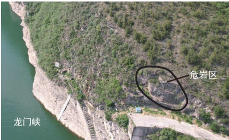
图 1 危岩区航拍全貌图
