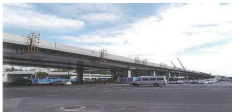
图5 钢箱梁防撞墙线形
