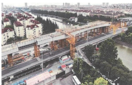
图4 川杨河桥上的吊装
