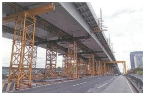
图2 支架法施工
