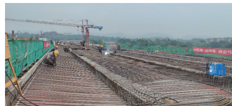
图6 顶板浇筑前施工现场照片
