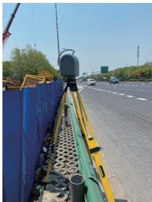
图5 本项目现场扫描照片
