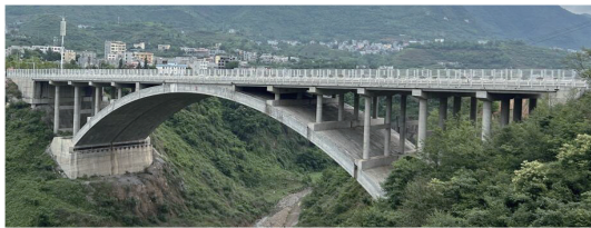
图 1 上承式钢筋混凝土拱桥
