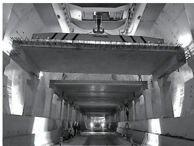
图5 预制车道板吊装
