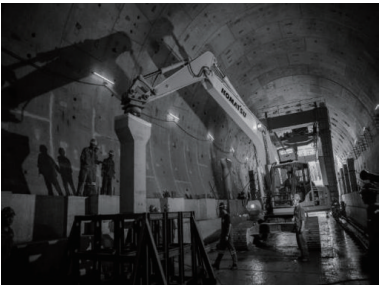
图12 预制立柱拼装机械手
