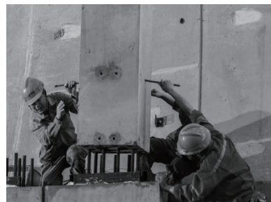
图4 预留插筋插入预制立柱灌浆套筒过程
