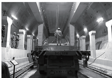
图6 预制车道板吊装
