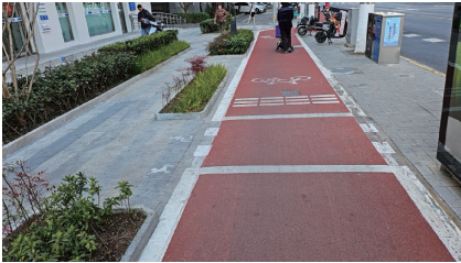
图 6 临平北路四平路公交站设置路面标记及减速标线实景
