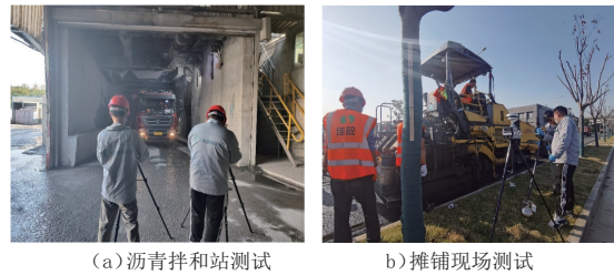
图2 沥青拌合站和摊铺现场排放气体测试
