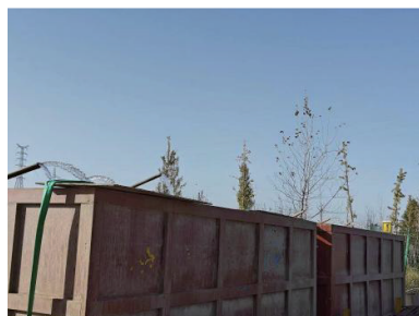
(a)循环水出水口
