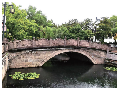
图3 凌霄桥-拱圈呈准悬链线形状
