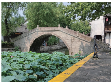
图2 谢公桥-单孔七折拱形石桥
