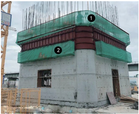
图6 定制吊篮实况图
