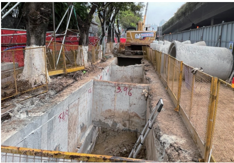
图 4 逆作法开挖支护现场图
