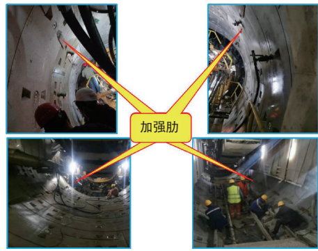
图5 管片加强肋设置情况图示
