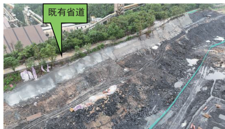
图1 毗邻省道产业园开挖路基边坡现场实景
