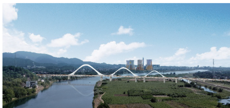
图1 婺江大桥主桥实景效果
