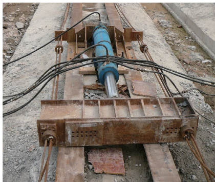
图7 遗址平移千斤顶
