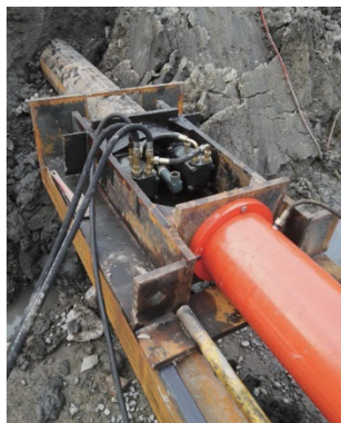
图4 顶进导轨
