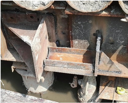
图 6 顶推用牛腿反力架
