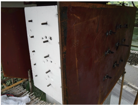
图4 钢板定位及安装
