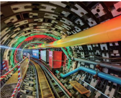
图6 R=80 m急曲线隧道实景
