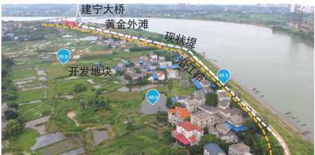
图9 沿江南路(枫溪大桥~建宁大桥)现场照片
