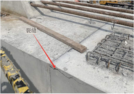
图 4 现场盖梁顶面
