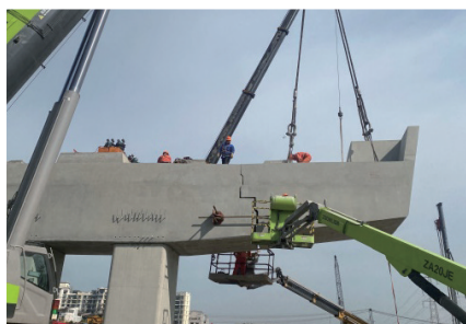
图6 节段盖梁安装
