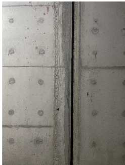
图3 某综合管廊变形缝修复图
