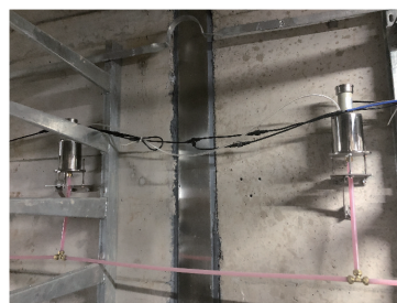
图 5 管廊内监测设备安装图
