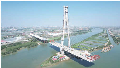
图 8 横门西特大桥主塔钢箱梁同步航拍图 4
