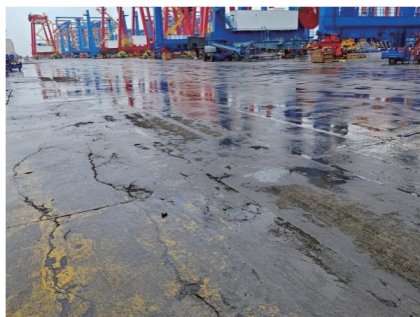
图1 现状水泥混凝土路面现场照片
