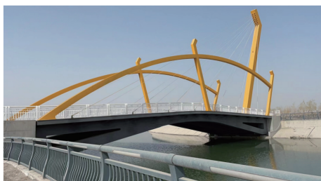
图1 景观装饰无背索斜拉桥建成后实景
