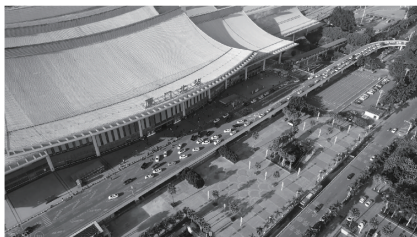
图4 平台一侧空闲一侧拥堵、上匝道非常拥堵
