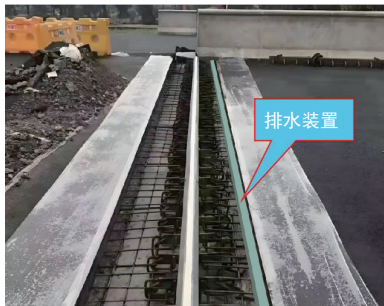
图 12 排水装置安装
