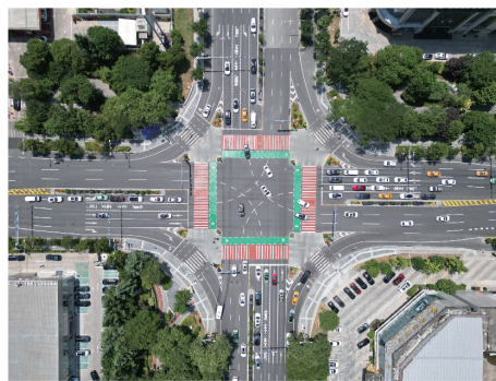
图5 改造后交叉口通行实景图
