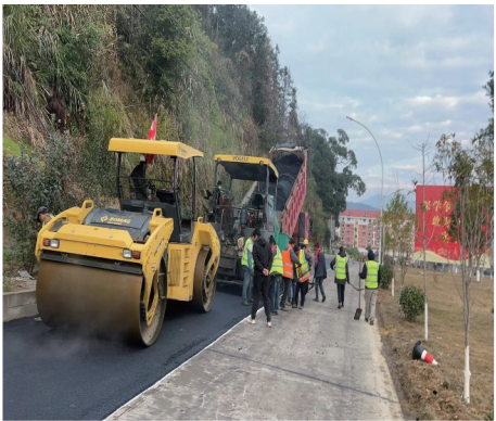
(a) 现场施工一
