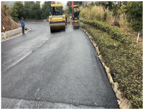
(b) 现场施工二
