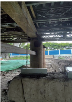
图7 传力杆焊接完成
