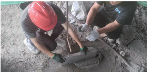
图6 设备安装照片
