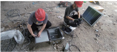
图5 综合箱体组装
