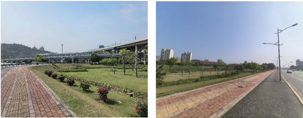
(a)金湾立交桥下 (b)珠海大道两侧
