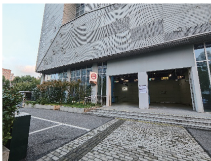
图2 上海轨道交通12号线宁国站5号口
