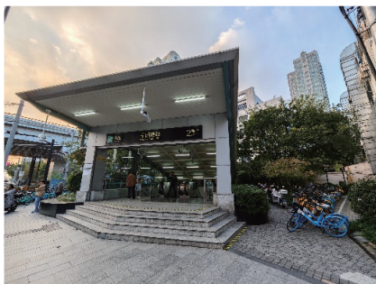
图1 上海轨道交通12号线宁国站2号口
