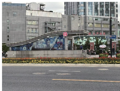
图 17 10号线五角场2号出入口
