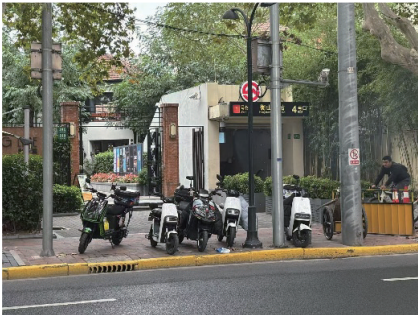
图 13 1 号衡山路站 4 号出入口
