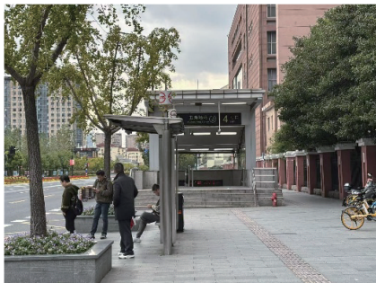
图 14 10号线五角场4号出入口
