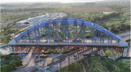
图7 跨 G205 国道桥现场施工照片
