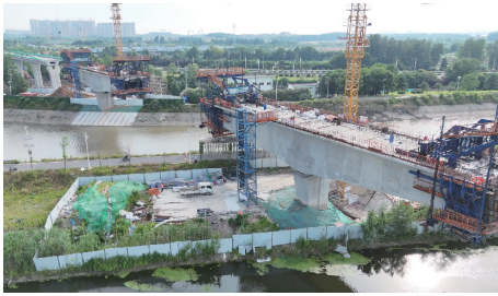
图4 跨江宁河桥现场施工照片
