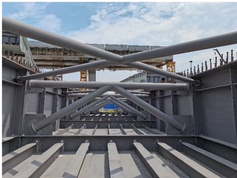
图5 钢混组合梁钢结构现场照片
