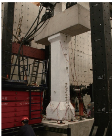
图1 桥墩UHPC连接试验
