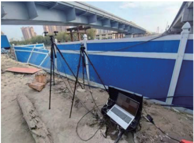
图 4 现场测量相机位置
