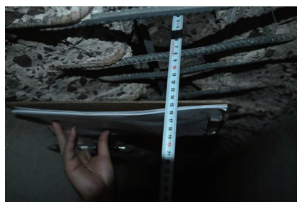
图4 湿接缝剥落最大深度 13.0 cm
