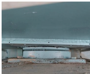
图11 配重施工后支座情况图
