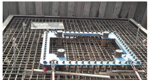
图4 固定端锚具定位
