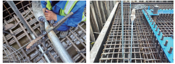
图3 注浆管固定和标识标注
