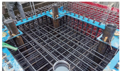
图5 锚固端注水密封检测
