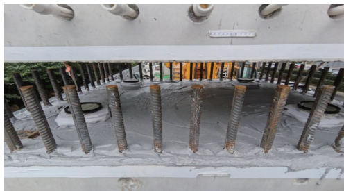
图6 预埋管道密封和拼接面坐浆
