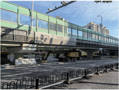
图 14 防撞墙外包铝板实景
