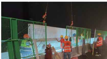
图10 预制节段防撞墙安装
