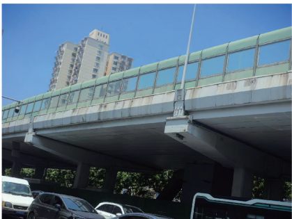
图8 防撞墙表面斑驳陆离,整体效果不佳
