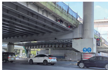
(b) 白天桥下正常开放交通
