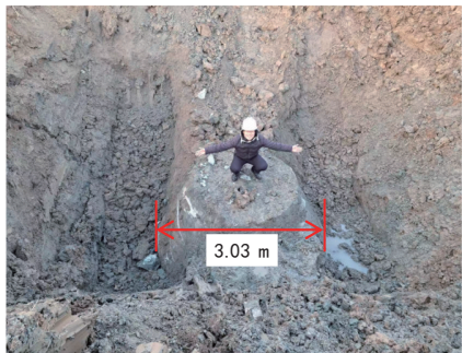
图10 现场浅层模型开挖实测与工艺验证照片
