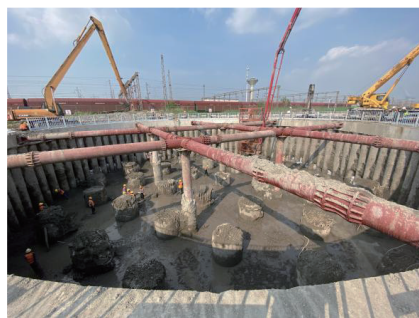
图 1 主墩固结扩盘桩群桩基础基坑开挖现场图
