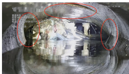
图6 HDPE管道CCTV影像图
