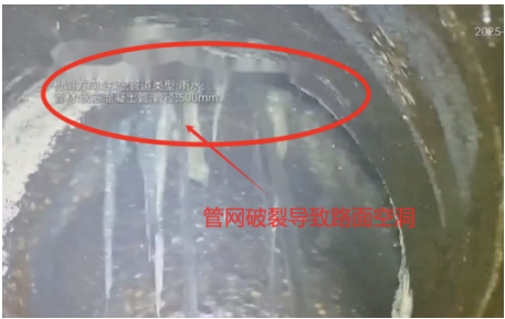
图 10 管道 CCTV 影像图
