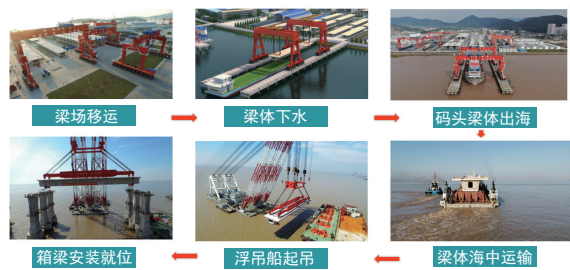
图 12 海中箱梁运架流程
