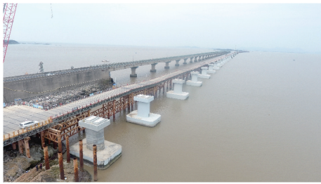
图4 桥墩现场实拍
