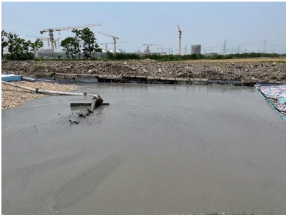
图 5 泵送浇筑
