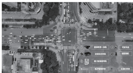
图6 交叉口智慧化提升改造实景图
