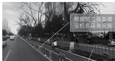
图9 道路增加机非隔离护栏实景图
