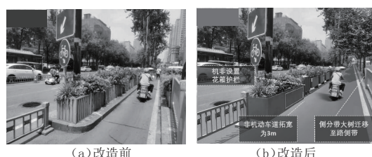
图10 侧分带改造,拓宽非机动车道路权示意图
