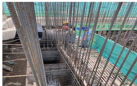
图5 出水钢管加固
