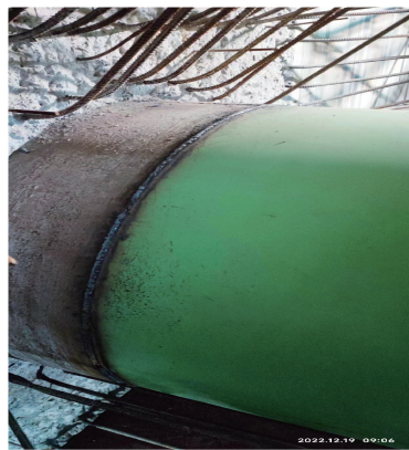
图6 水泵出水钢管安装及焊接
